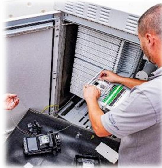
Montagearbeiten an Verteiler
