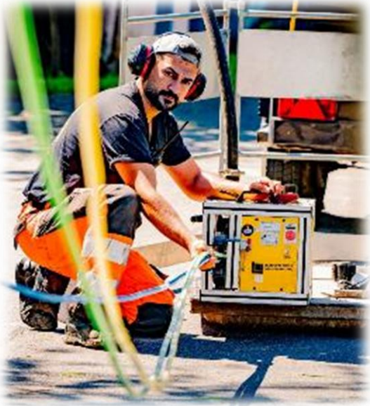
Einblasen der GF-Kabel
